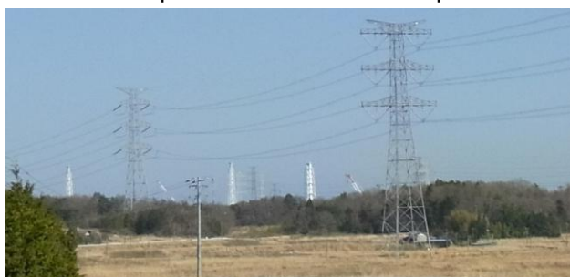
六号線の車内から福島第一原発排気塔を見る
