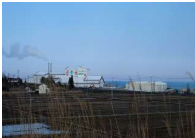
富岡町の焼却施設(左側。煙が出ている)と大型のテント張りの焼却灰保管施設
