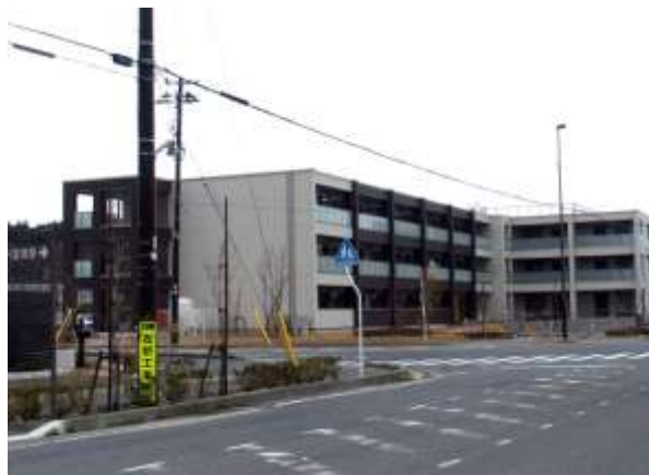
駅の北側に建てられた公営住宅。駅周辺を含む地域がいわゆる復興タウン。元の住民の帰還は数%で、高齢者が多い。復興の中心は農業だが、廃炉企業等に頼らざるを得ない姿が見える。
